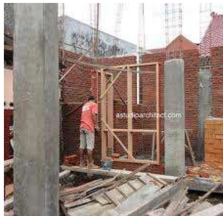
Gb. Kusen jendela yang sudah terpasang
