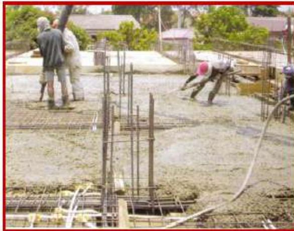
*Gambar pengecoran beton*
