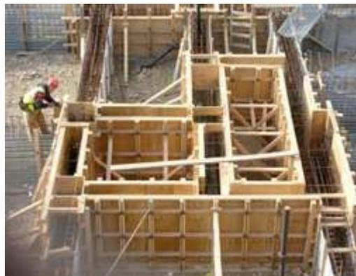
Gambar cetakan/acuan (bekisting), jarak antar tiang penyangga  $\leq 60$  cm
