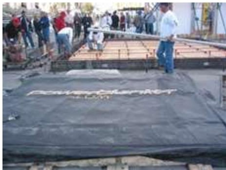
Penutupan dengan "selimut" dimaksudkan agar penguapan (penurunan air semen) tidak berlangsung terlalu cepat selama proses pembentukan beton baru berjalan.
