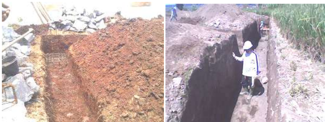
Gambar penggalian tanah lubang pondasi
