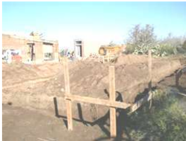
Gambar papan bangunan pada patok terluar.
