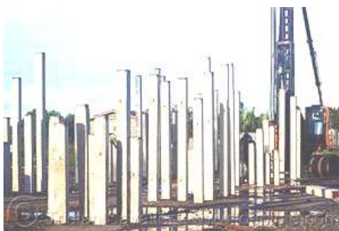
Gambar pondasi tiang pancang beton
