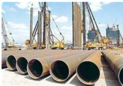
Gambar tiang pancang pipa baja
