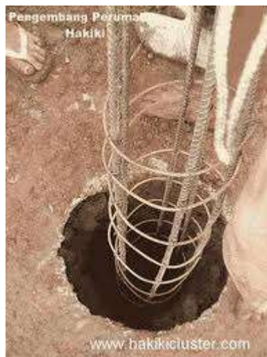
Gambar pondasi bor pile
