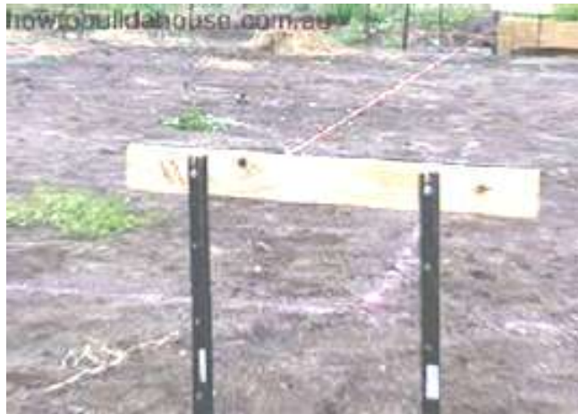
Gambar tarikan benang antar papan bangunan
