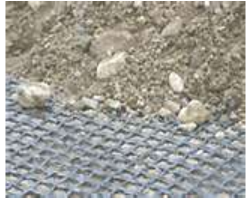
Perkuatan dasar pondasi dengan geocomposit
