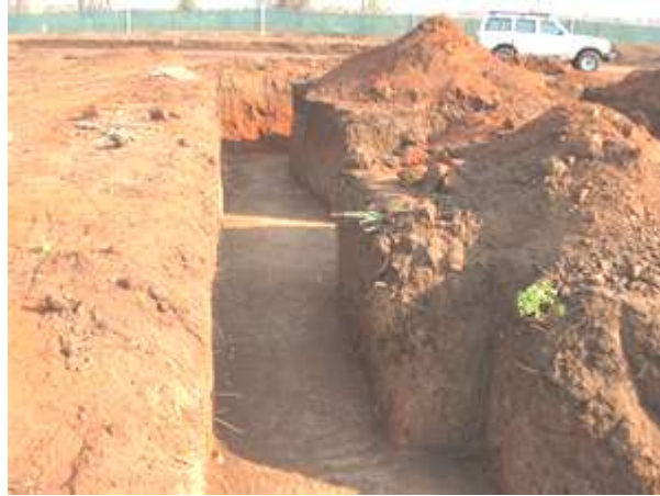
Gambar perataan tanah dasar pondasi
