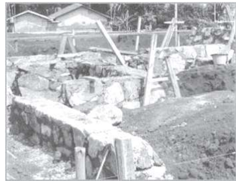
Gambar pondasi lajur batu kali
