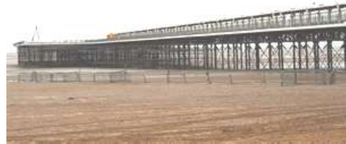
Gambar pondasi tiang pancang besi
