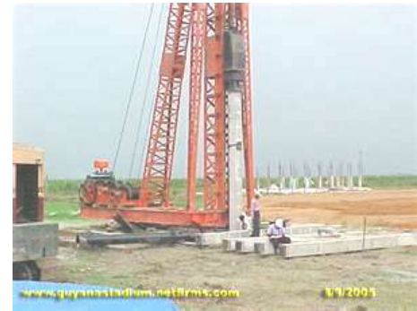
Gambar pemancangan tiang pancang beton
