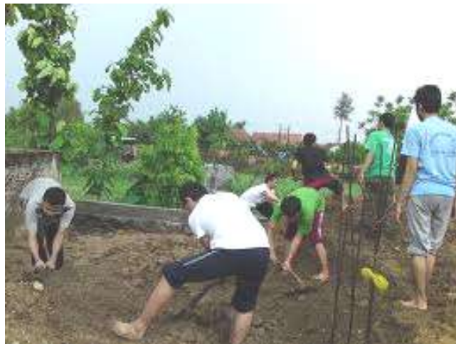
Gambar perataan tanah sisi pondasi
