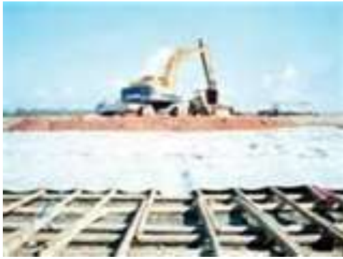
Gambar perkuatan tanah dengan anyaman bambu
