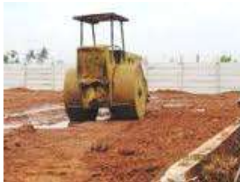
Gambar pemadatan tanah urugan dengan mesin pemadat
