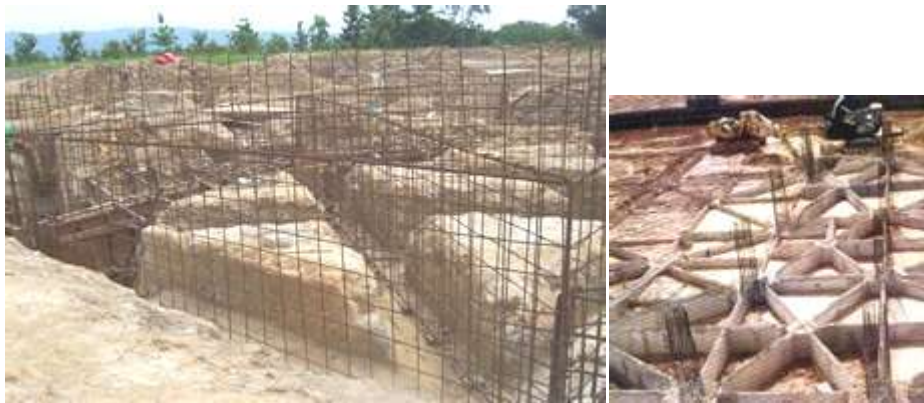
Gambar pondasi konstruksi sarang laba-laba
