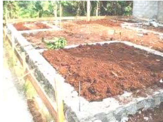
Gambar urugan tanah pada sisi pondasi
