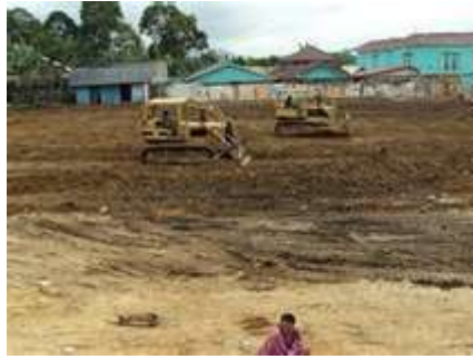
Gambar pelaksanaan dan alat berat (bulldozer) untuk perataan tanah
