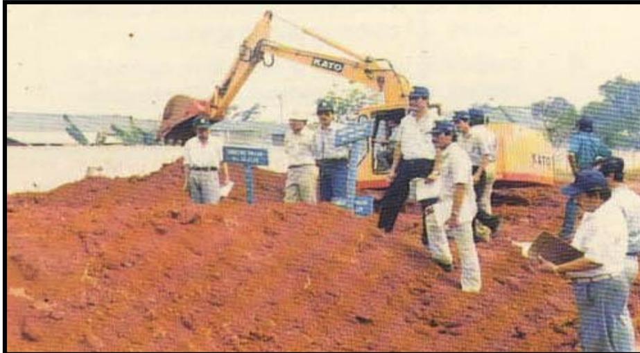
*Gb. Model Test Timbunan Tanah tanggul saluran*
